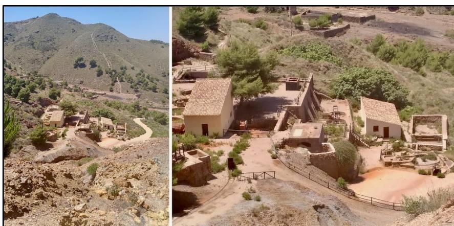
*Figura 3.8: Entorno Parque Minero de La Unión. Lavadero de Remunerada, construido en 1920 y en funcionamiento hasta 1957. Es un lavadero gravimétrico que separaba el mineral por medios mecánicos del cual se han recuperado el conjunto de sus instalaciones. (Fuente: Archivo personal Pablo Olmos Fraile)*
